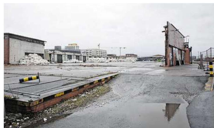
Zum Europahafenbecken hin sind bereits große Teile des alten Schuppens 3 abgerissen worden. Nur das südöstliche Drittel des rund 400 Meter langen Gebäudes wird als Gewerbefläche erhalten und umgebaut. FOTO: SCHEITZ
