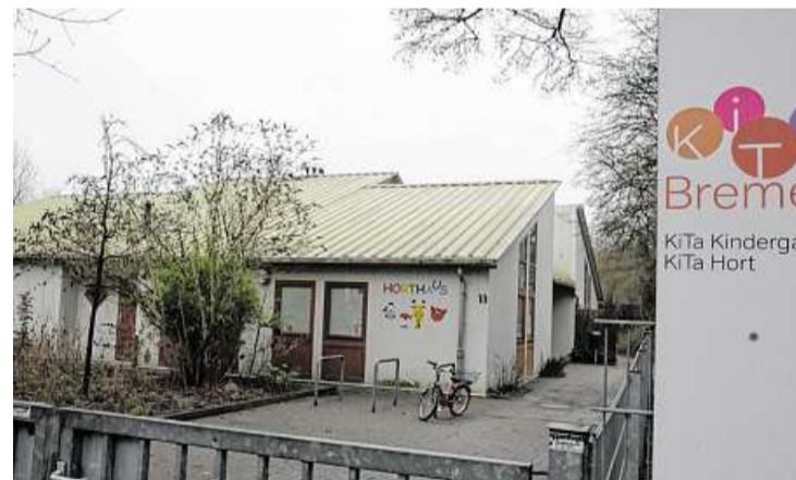
Das alte Horthaus an der Dresdener Straße soll im kommenden Jahr abgerissen werden. An seiner Stelle soll ein Mehrzweckgebäude entstehen, das gemeinsam von Kindergarten, Hort- und Schulkindern genutzt werden kann.
